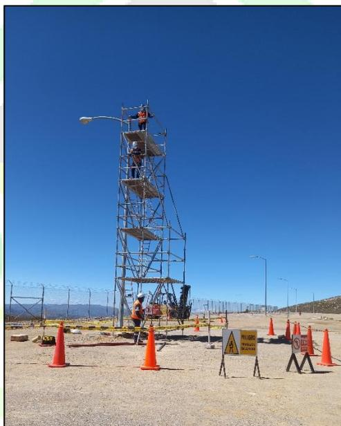
**Artículo 97°** Solo está permitido el uso de andamios multidireccionales, y para el armado y desarmado se requiere el uso de martillo andamiero.
